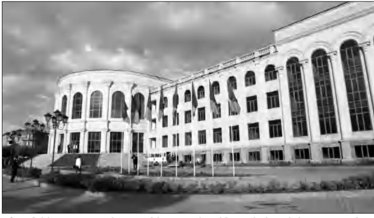
Գյումրիի քաղաքապետարանի այս շքեղ շենքը դեռևս չի կարող դառնալ աղետի գոտու վերակառուցման խորհրդանշան:
