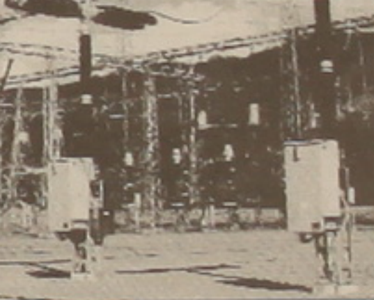
110 կՎ ենթակայանի վերազինումը ABB-ի ժամանակակից սարքավորումներով:
